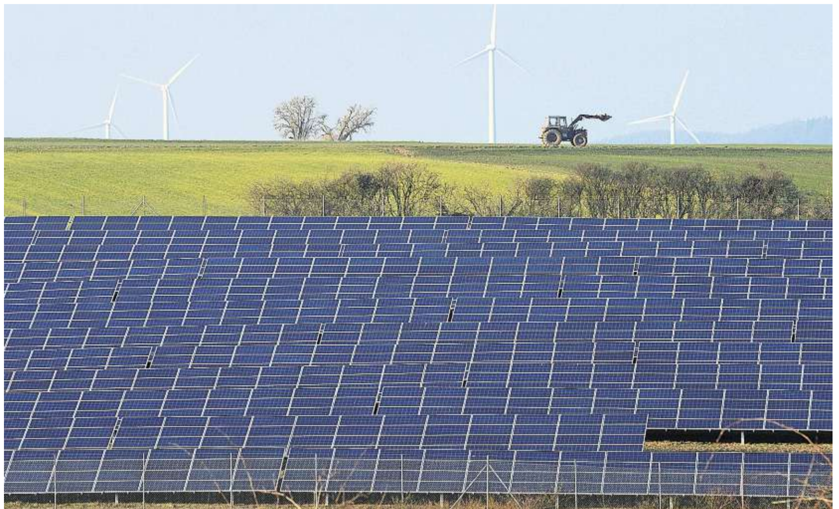
Photovoltaikanlagen sind ein Kernstück der Regionalwerke, die ihre Mitglieder mit Energie versorgen.
